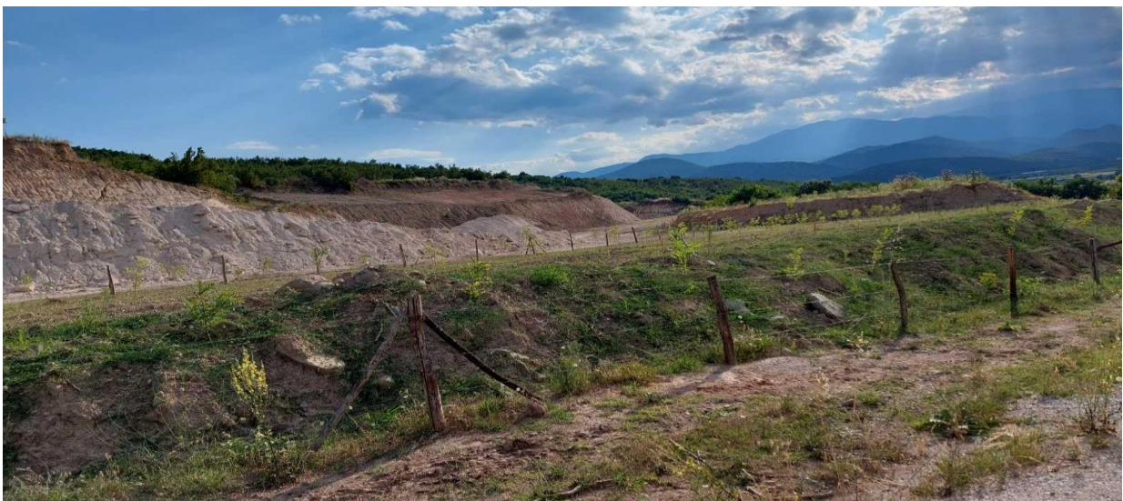
ΕΙΚΟΝΑ 4.: Άποψη της αποκατεστημένης έκτασης του λατομικού χώρου, από την πλευρά του αγροτικού δρόμου.
